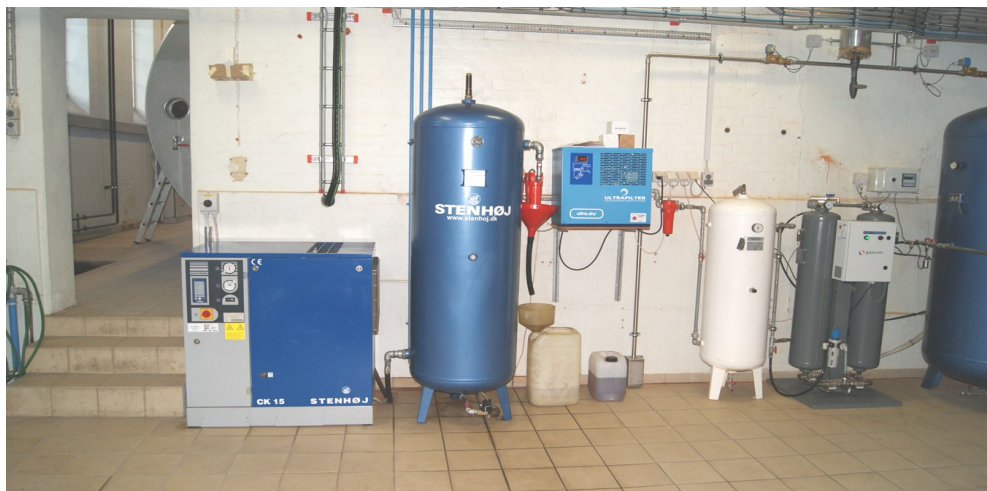
Nitrogenanlæg Søndergade – nedenfor tilsvarende anlæg på Lergården.
