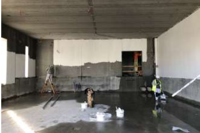
Ydervæggen i biomasselageret består af to vægge, for at give den nødvendige ventilation i rummet.
