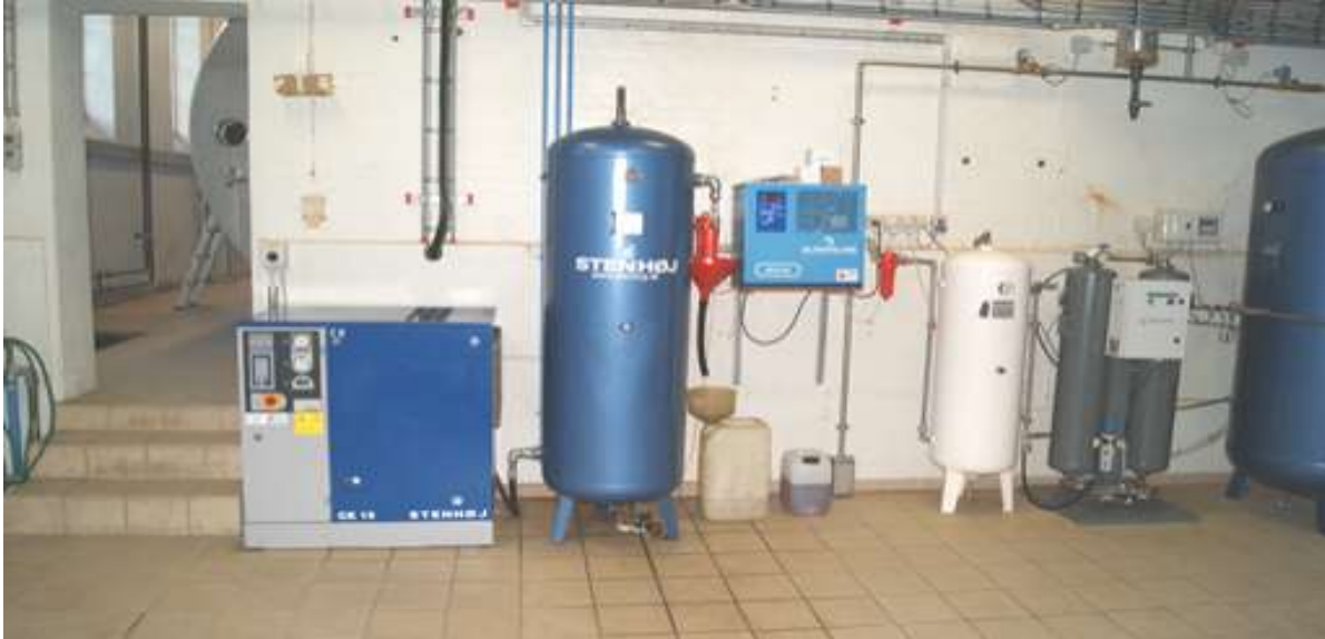
Nitrogenanæg i Søndergade.
