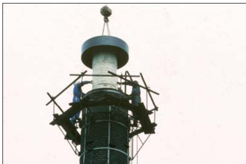
Etablering af isolerende indsats ned gennem den høje skorsten
