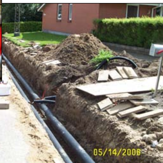
Renovering af Kirkevej i 2008
