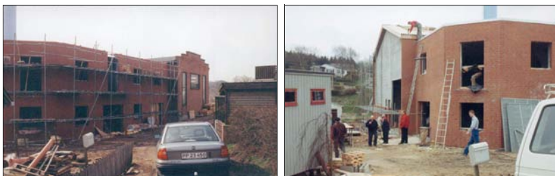
Varmeværket under ombygning til Kraftvarmeværk i 1994
