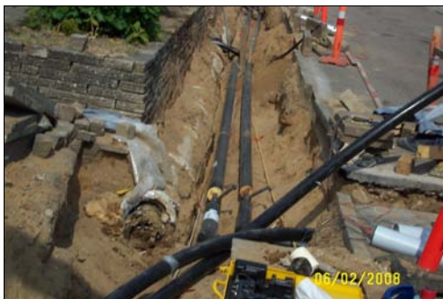
Gamle kanal rør tv. - ye prærrør th.
